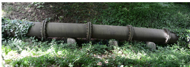
Canalisation en fonte de 1865 remontant les eaux de la machine de Dufrayer
