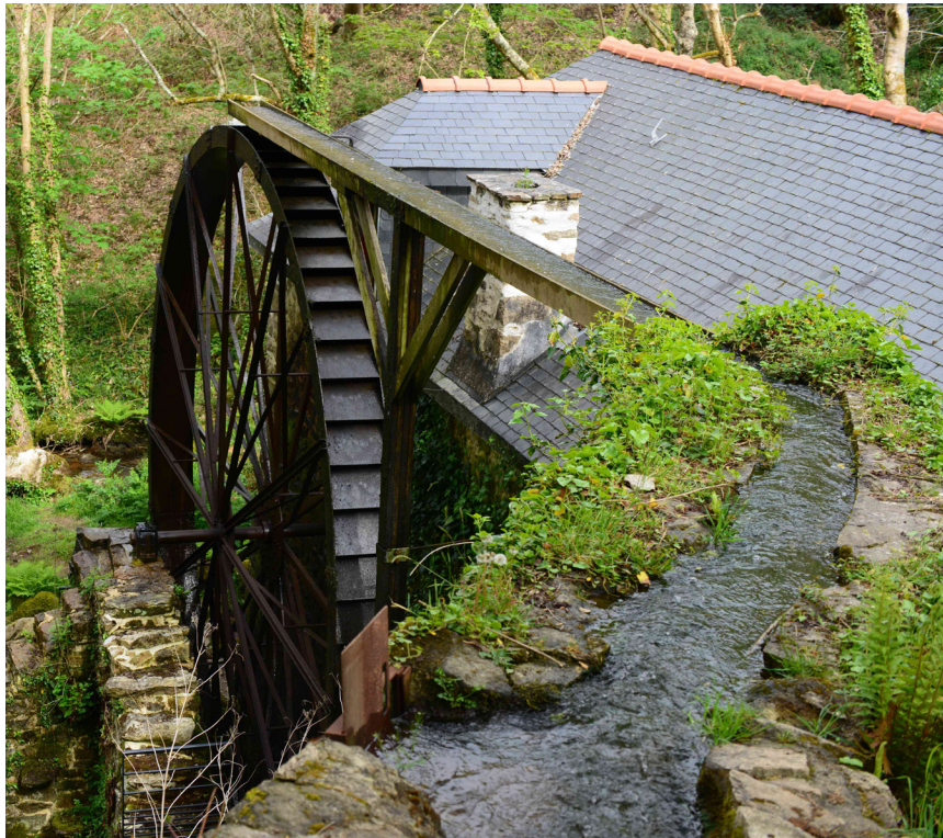
Moulin à eau de Kériolet (Finistère), exemple de mouvement obtenu par l'eau : L'eau est amenée au-dessus de la roue (ici roue à godets). La force motrice est obtenue par l'énergie potentielle de l'eau qui reste dans les godets ce qui va entraîner la roue en rotation. Chaque godet rempli en haut, se videra après un demi-tour en bas du moulin.
