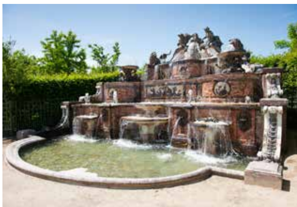
Le Buffet d'eau avant restauration © château de Versailles / T. Garnier
