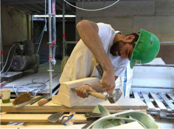
Septembre : taille de pierre sur site.
