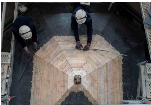
Octobre : réfection de la couverture en ardoise.
