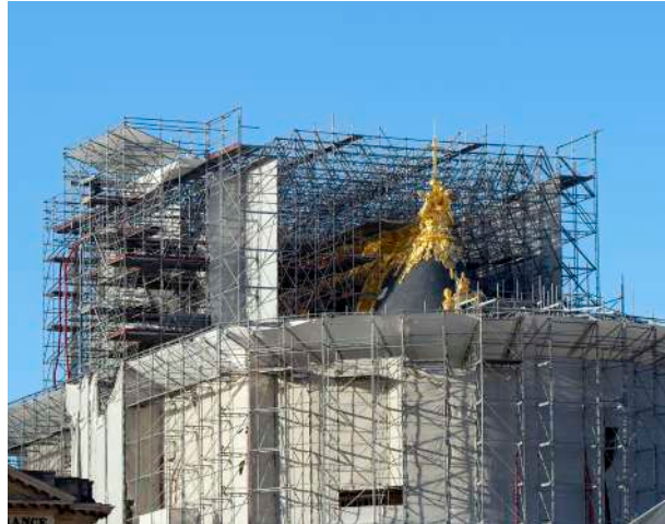
Novembre : poursuite du démontage de l'échafaudage.
