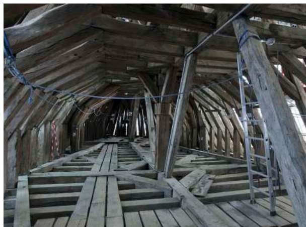
Charpente mise à nue © château de Versailles, Didier Saulnier
