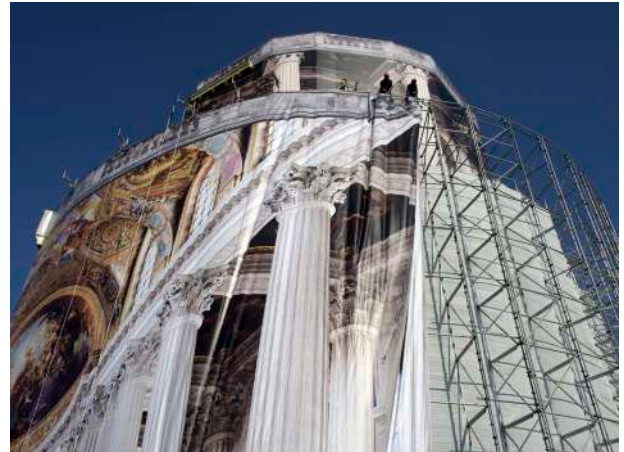
Juin-juillet : dépose des chéneaux en pierre du grand comble.
