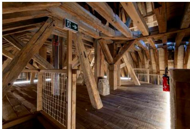
Charpente après restauration © château de Versailles, Didier Saulnier
