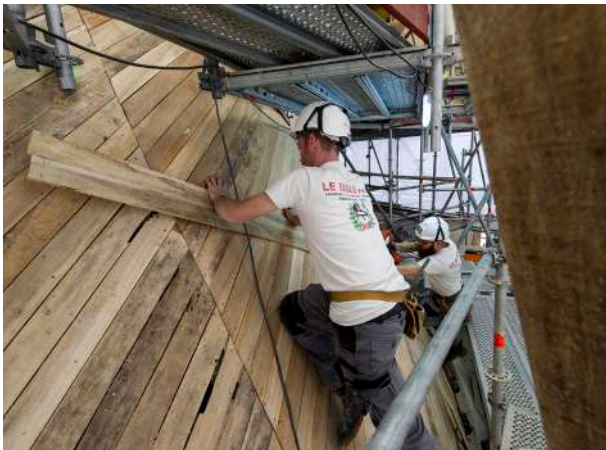
Septembre : restauration de la toiture.
