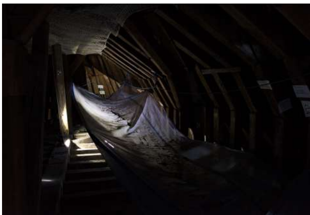
Charpente avant restauration © château de Versailles, Thomas Garnier
