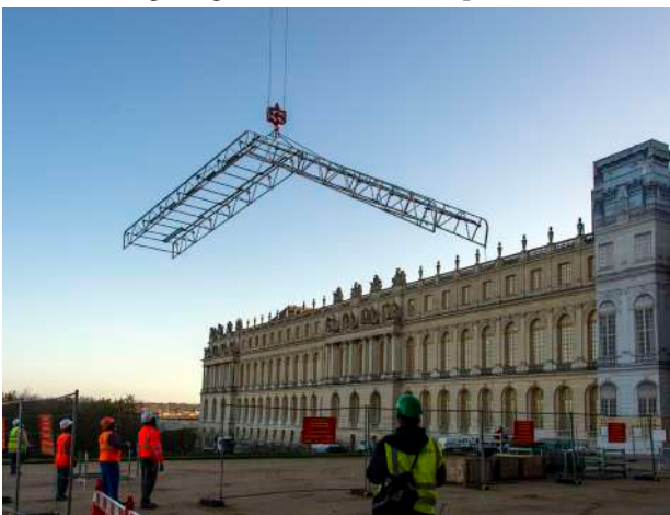
Novembre : grutage des fermes métalliques.
