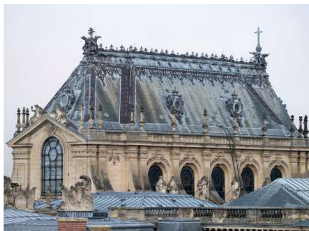
Toiture du chevet est avant restauration © château de Versailles, Thomas Garnier
