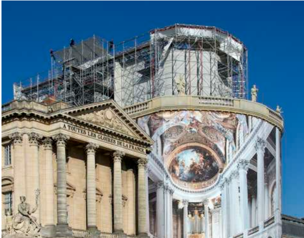
Novembre : début du démontage de l'échafaudage.
