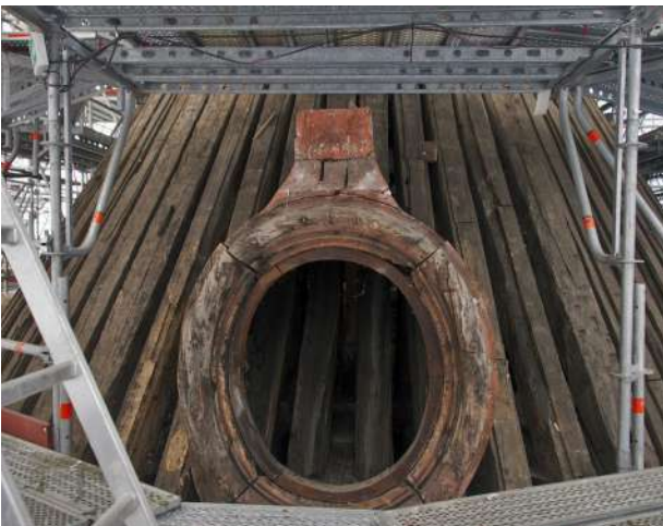
Mars-avril : dépose de la couverture en plomb et ardoise.
