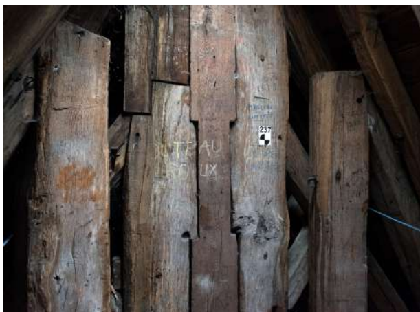
Charpente avant restauration © château de Versailles, Thomas Garnier
