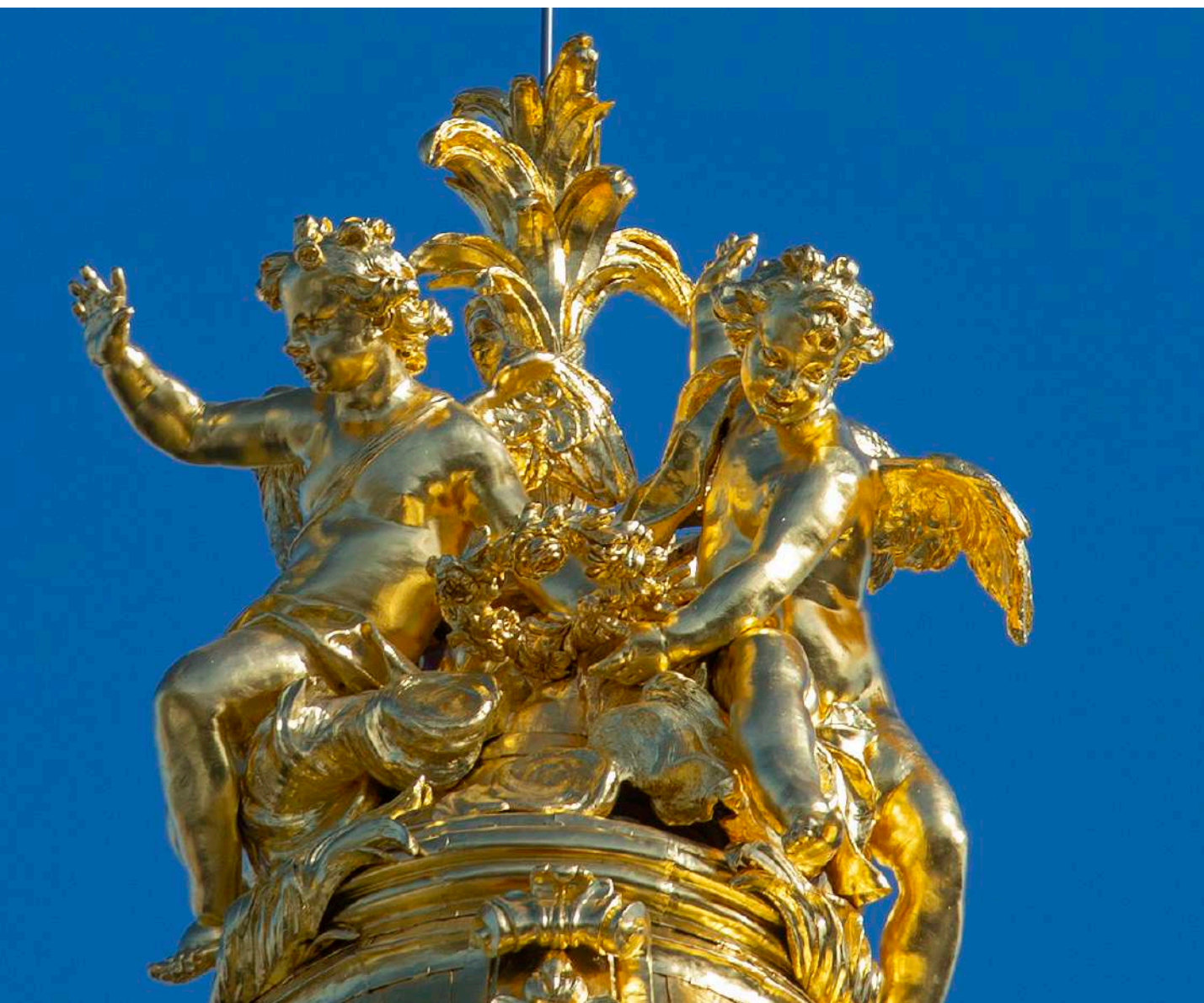
Modénature en plomb de la partie haute de la toiture (côté ouest) après restauration © château de Versailles
