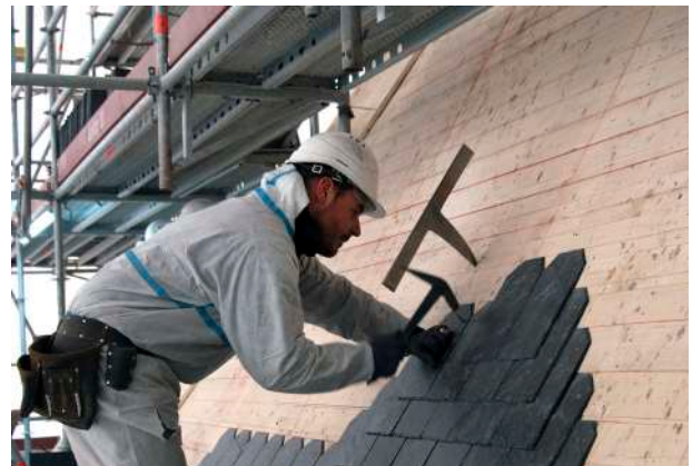
Décembre : réfection de la couverture en ardoise.
