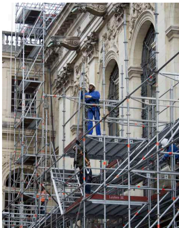
Montage de l'échafaudage © château de Versailles, Didier Saulnier
