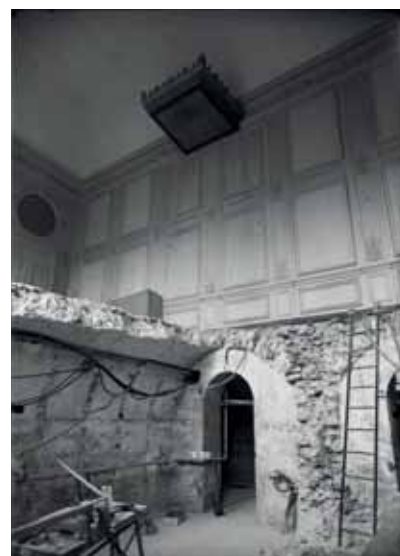
Chambre de la reine des Belges. Les sols sont creusés pour faire passer câbles et tuyaux. © Archives du château de Versailles
