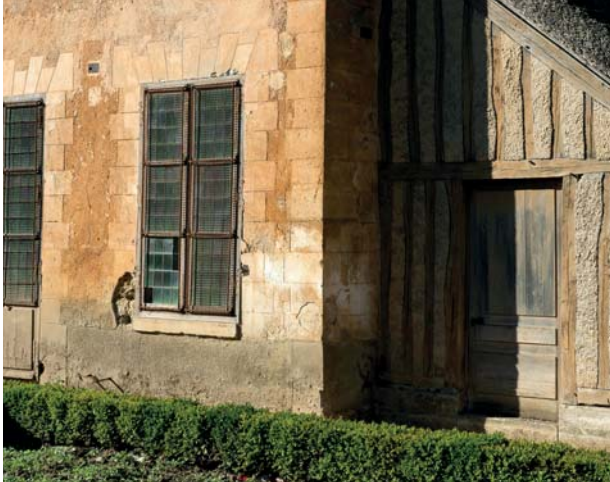
Usure des revêtements extérieurs de la Maison du Billard © Château de Versailles / Didier Saulnier
