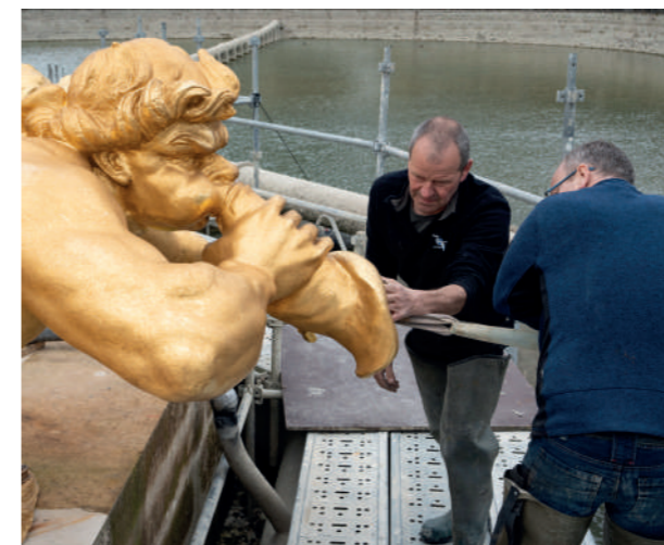
Installation d'un nouvel ajutage sur un triton © château de Versailles, T. Garnier
