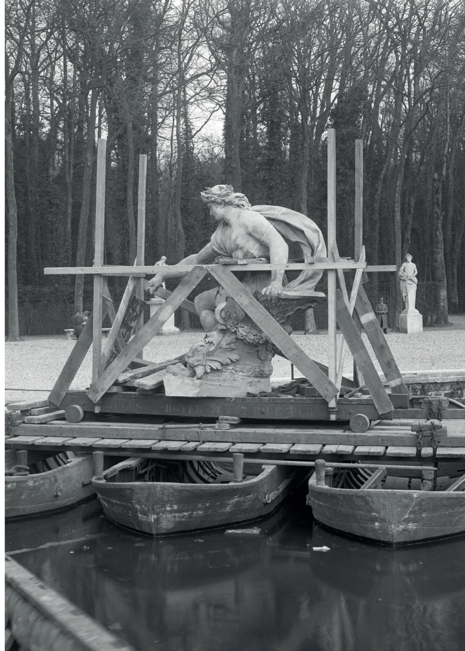
Dépose du groupe sculpté pour sa restauration dans les années 1929-1933 © Archives du château de Versailles
