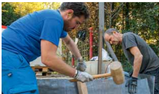
Rabattage du plomb pour l'étanchéité du bassin inférieur © château de Versailles, D. Saulnier
