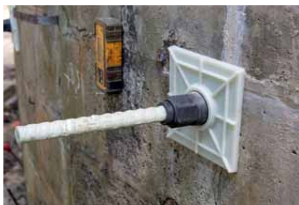
Tirant apparaissant au dos de la maçonnerie du Buffet d'eau et capteur de contrôle de la stabilité de la fontaine et des sols d'assise © château de Versailles, D. Saulnier
