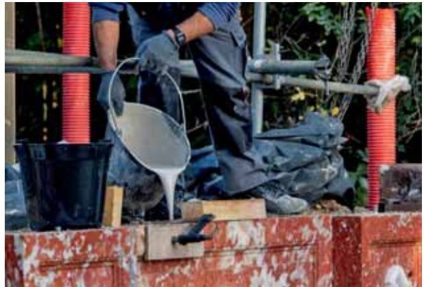
Coulage de chaux liquide entre pierre et marbre © château de Versailles, D. Saulnier
