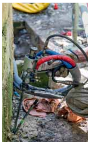
Injections de résine sous la maçonnerie du Buffet d'eau © château de Versailles, D. Saulnier
