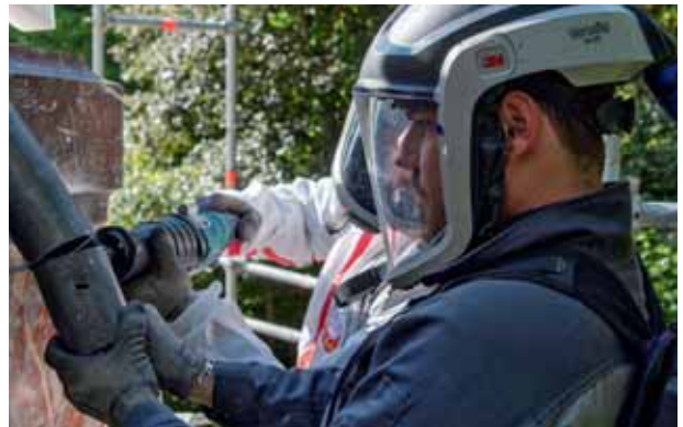
Ajustement des conduites en plomb au revers de la structure © château de Versailles, D. Saulnier
