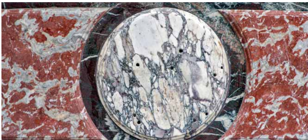
Décor de marbre du Buffet d'eau après restauration, avant la repose des ornements en plomb dorés © château de Versailles, D. Saulnier
