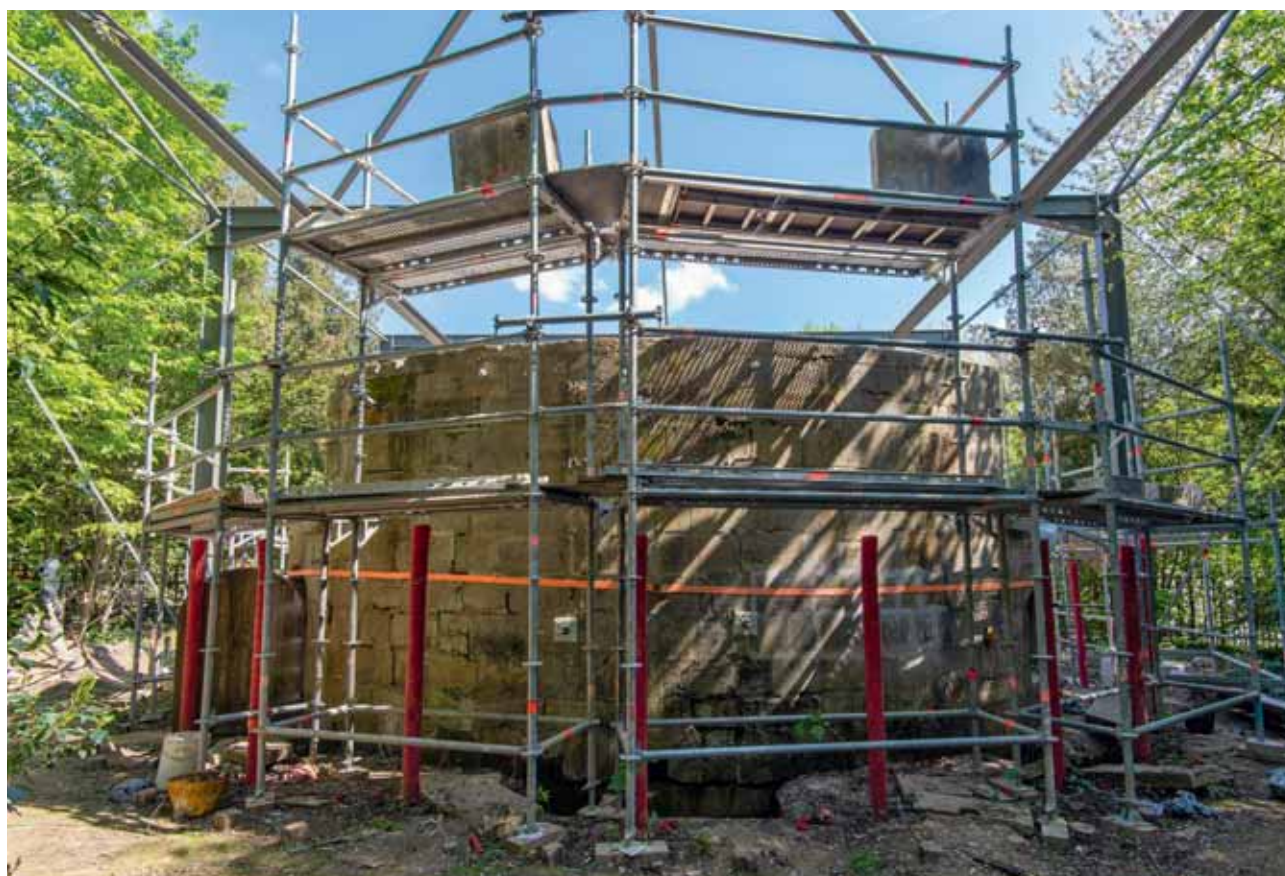
Chantier de restauration du Buffet d'eau, maçonnerie arrière de la fontaine © château de Versailles, D. Saulnier
