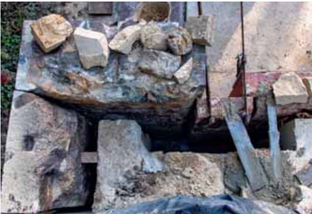
Comblement des réservations entre structure maçonnée et marbre de parement après pose des agrafes © château de Versailles, D. Saulnier
