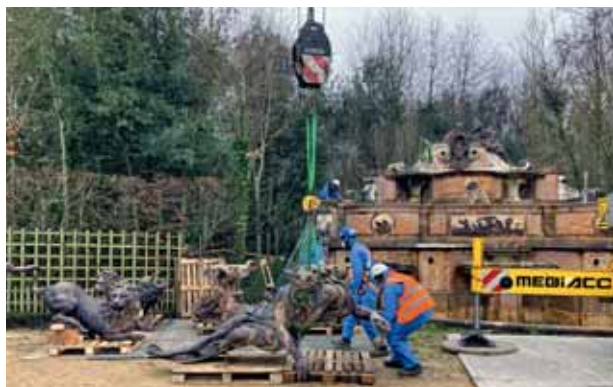
Dépose des ornements de plomb © château de Versailles, J. Camus
