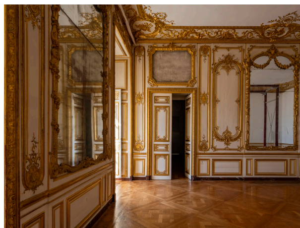
Chambre du Dauphin avant restauration, 2020 © château de Versailles / T. Garnier
