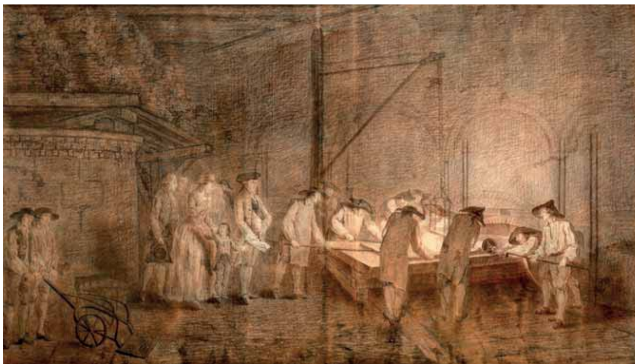
Coulée d'une glace à Saint-Gobain (Picardie) en présence du directeur Pierre Delaunay-Deslandes, vers 1770-1780. © Archives de Saint-Gobain.
