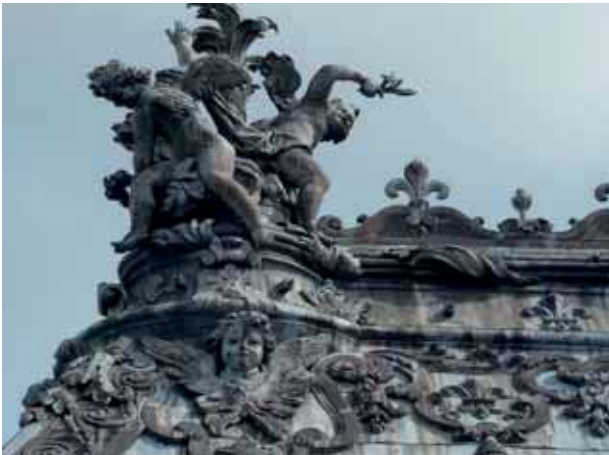
Modénature en plomb de la partie haute de la toiture © DR
