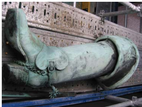
Corrosion des bronzes sur une des bottes de Louis XIV © Cabinet Didier
