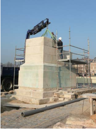
Chantier de réinstallation du piédestal sur la place d'Armes, mars 2009 © Cabinet Didier
