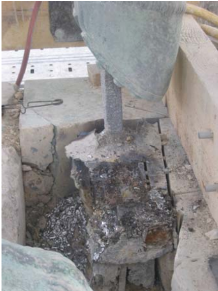
Enlèvement des enclaves du cheval au droit du piédestal en pierre, janvier 2006 © Cabinet Didier
